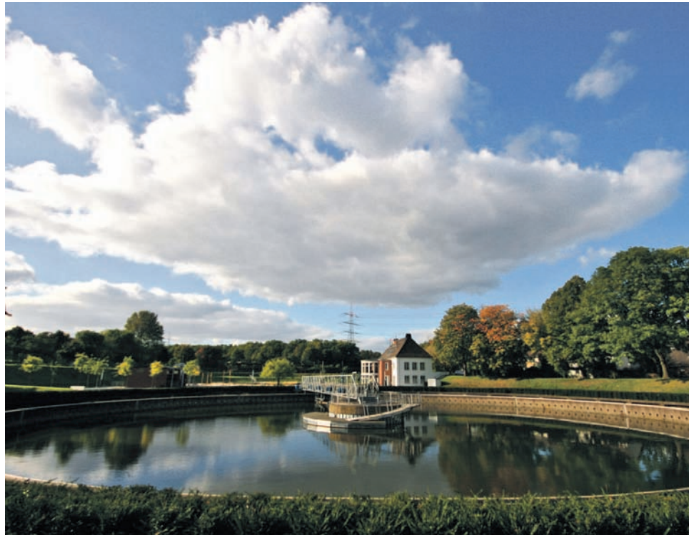
Bis 1997 waren die Klärbecken noch in Betrieb. Heute ist der Bernepark ein beliebtes Naherholungsziel – für Bottroper wie auch für Menschen aus den umliegenden Städten. FOTOS: DIETER PFENNIGWERTH
